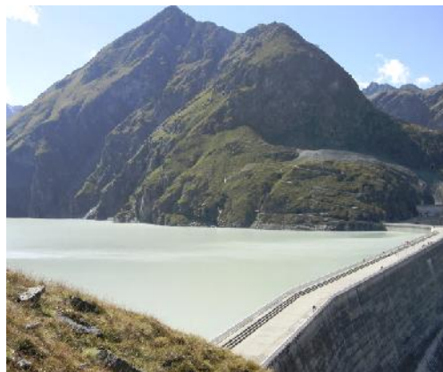
Le barrage de la Grande-Dixence (VS)
